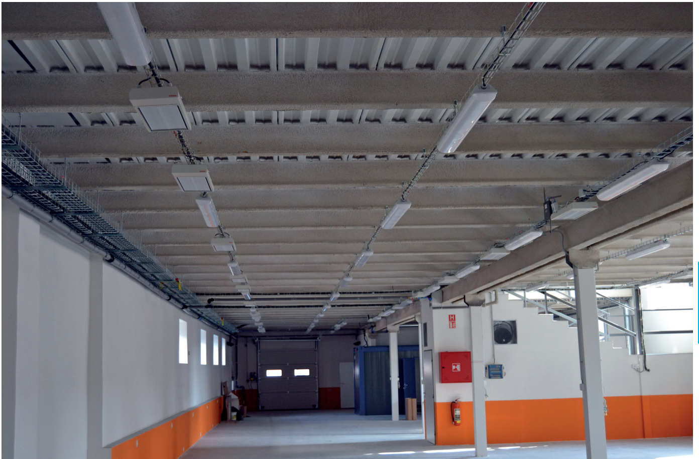
Strop z trapézového plechu
