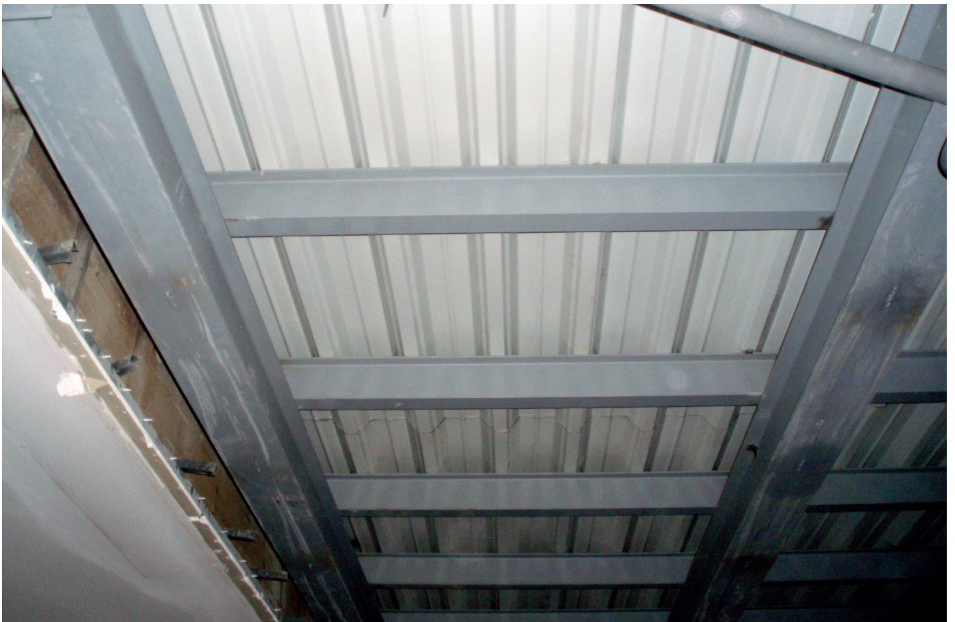
Strop z trapézového plechu
