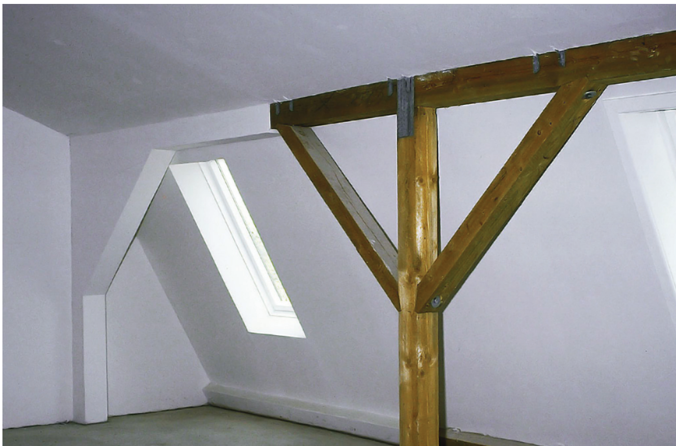
Podhled PROMATECT® pod střešní konstrukcí
