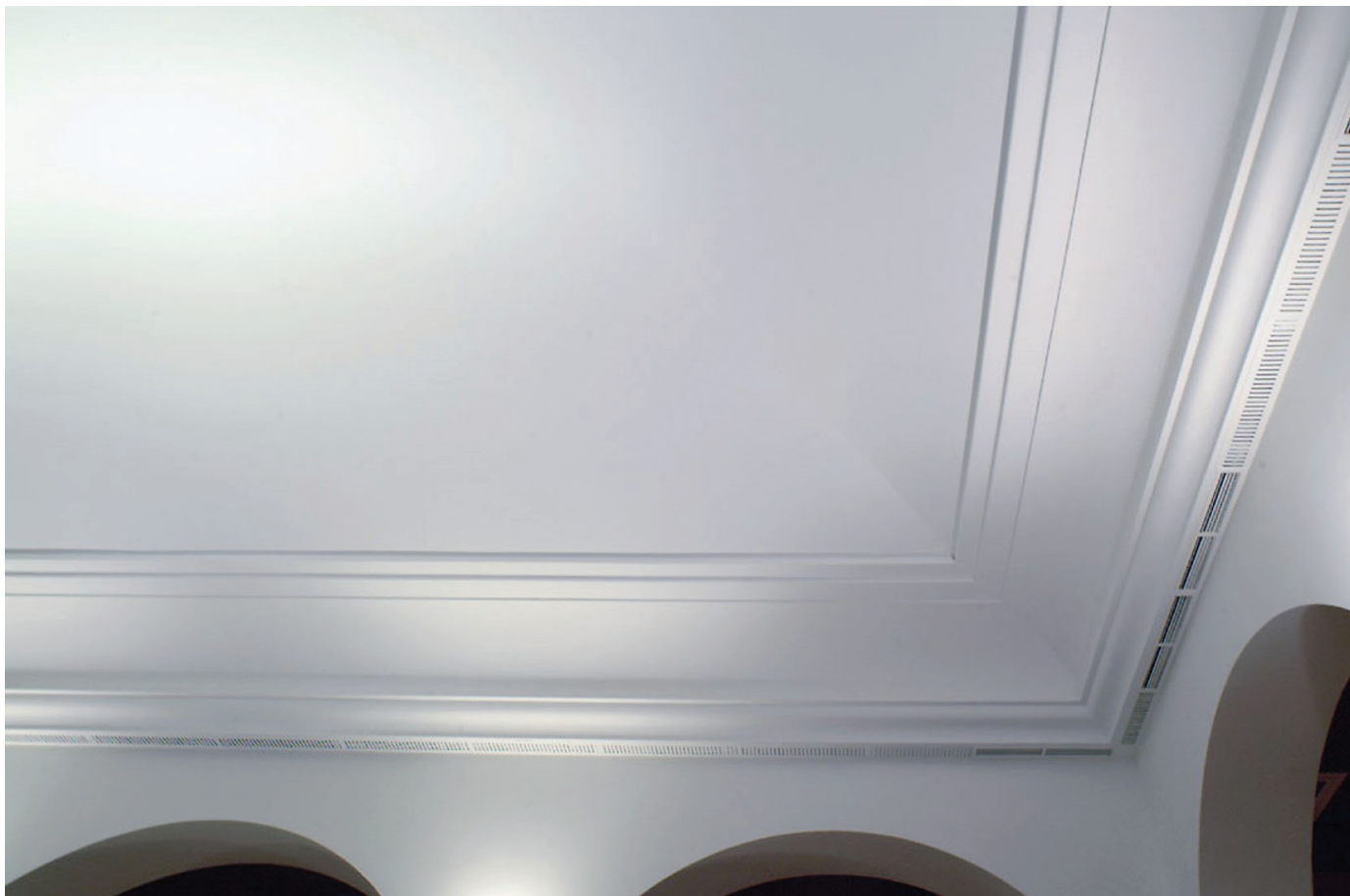
Podhled PROMATECT® pod dřevěným trámovým stropem
